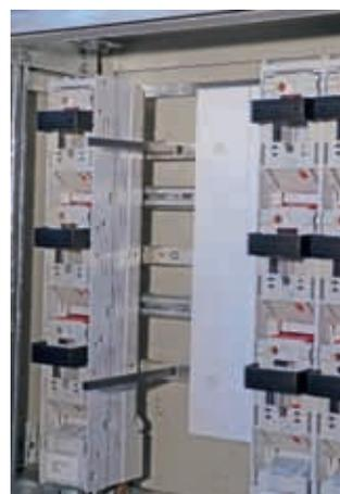
Obere und untere Montagehilfe in die Sammelschiene eingeschraubt.
