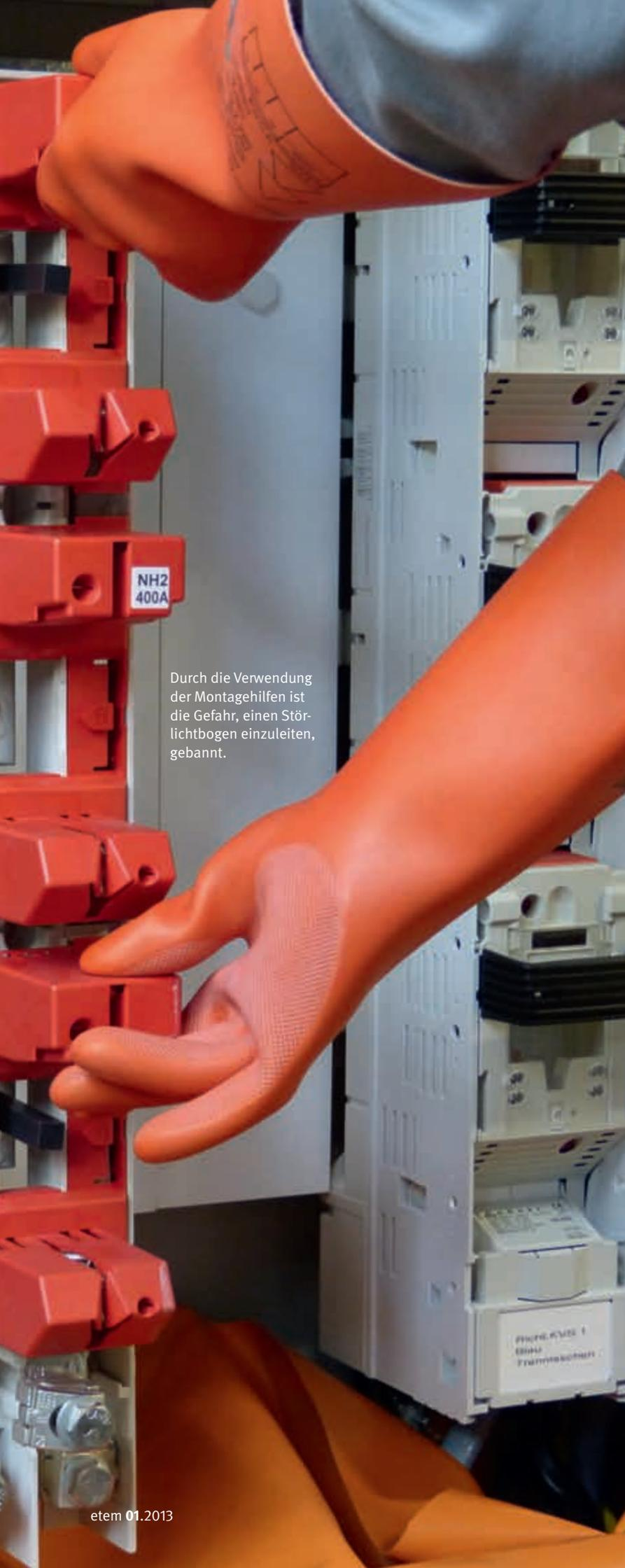
Durch die Verwendung der Montagehilfen ist die Gefahr, einen Störlichtbogen einzuleiten, gebannt.
