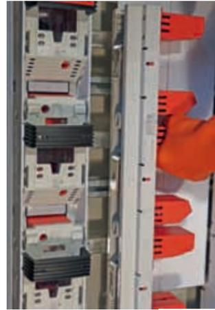
Mit der Anschlussfahne kann der geringe Abstand zwischen Sammelschiene und geerdetem Tragegerüst überbrückt werden.
