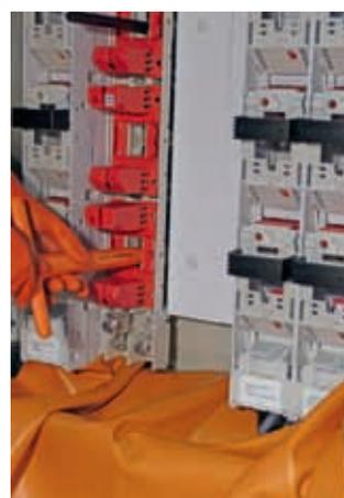
Durch Kontaktierung der mittleren Phase ist die NH-Sicherungslastschaltleiste fixiert. Die untere Montagehilfe ist demontiert, die untere Phase wird kontaktiert.
